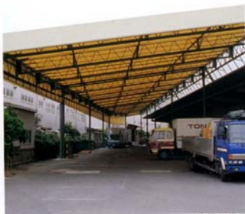
荷捌き場上屋
