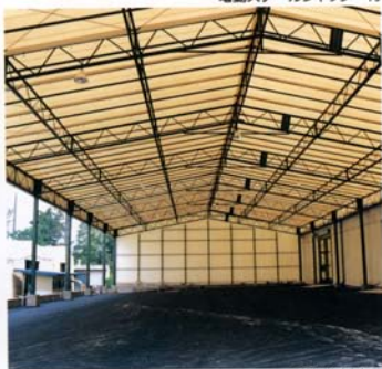
荷捌き場上屋
